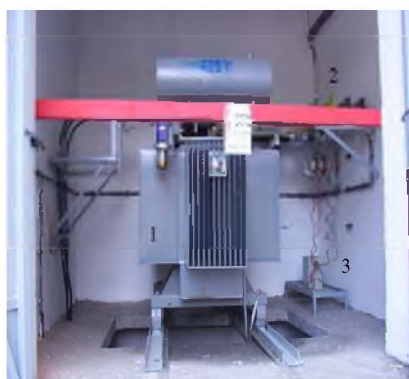
Слика 11.14 Положак кондензатора за компензацију реактивне снаге потребне за магнећење трансформатора
