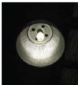
Слика 10.6 Метал-халогена сијалица за расвету фабричке хале
