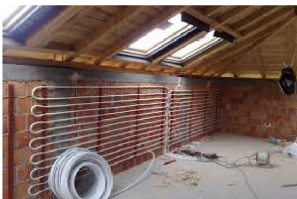
Слика 15.11 Постављање зидног грејања/хлађења
