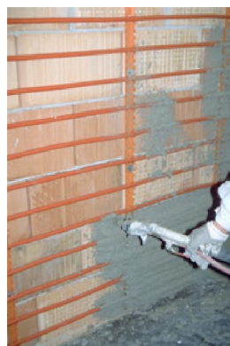
Слика 15.11 Постављање зидног грејања/хлађења
