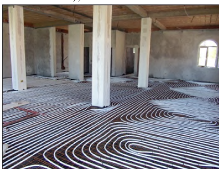
Слика 15.10 Цевима за подно грејање пре постављања завршног слоја
